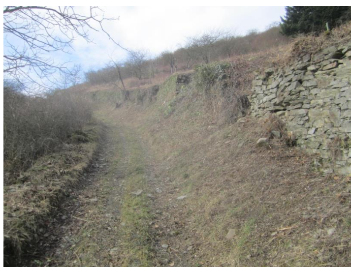
Nach der Freilegung der Mauern
