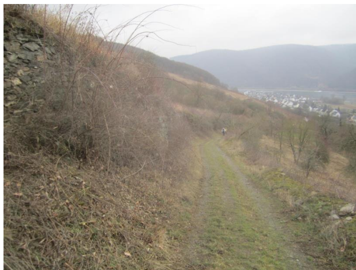
Mauerbereiche vor der Arbeit
